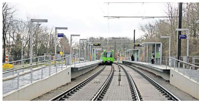
Die Stadtbahnhaltestelle Altwarmbüchen Zentrum wird seit Montag bis Ende April saniert.
